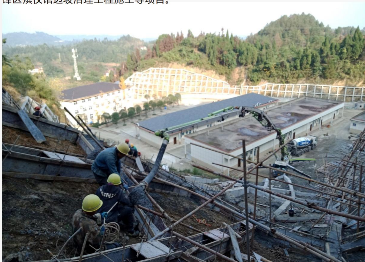
广安边坡治理工程施工现场
