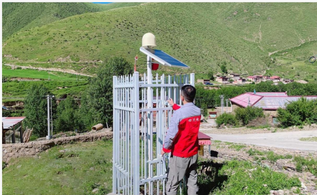
甘孜县泥石流排查
